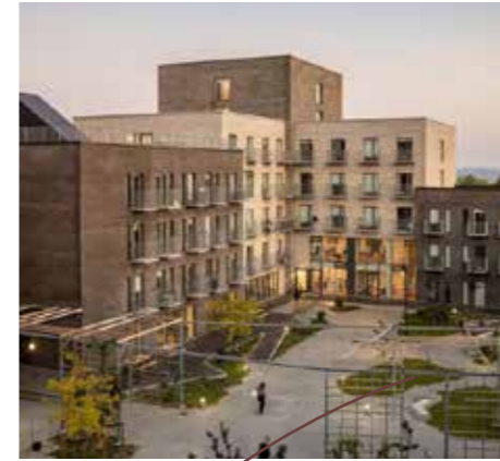
Leilighetsbygg som støyskjerming
