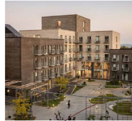
Leilighetsbygg som støyskjerming
